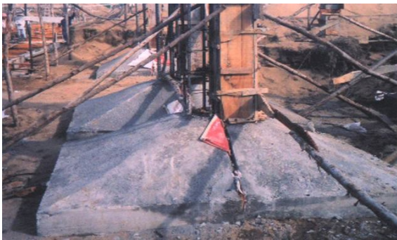
Hình 2.1 - Móng đơn dưới cột
