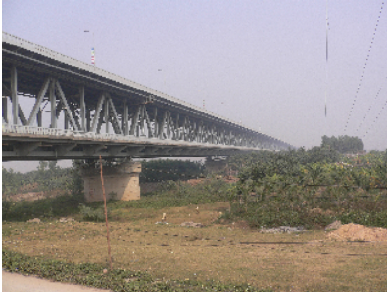
Hình 1.4- Nhịp giàn thép cầu Thăng long.
