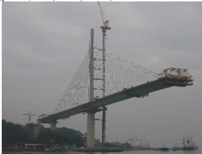
Hình 1.5- Cầu Bãi Cháy giai đoạn thi công đúc hẫng dầm cứng.
