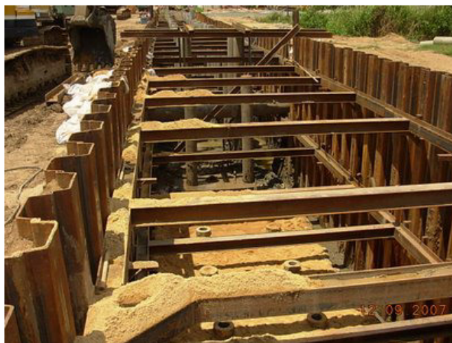
Hình 3.11- Hình thức liên kết đầu CVT vào khung chống
