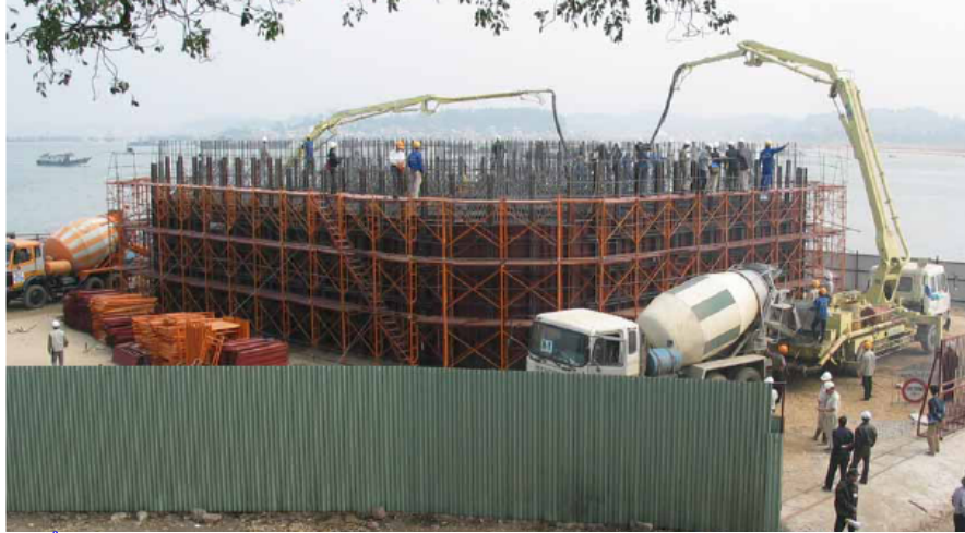
Đổ bê tông khoang làm việc ( ảnh lấy từ Workshop Baichay Bridge)
