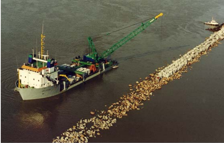
Hình 5.8: Thi công đê phá sóng dùng cần cầu trên phao nổi
