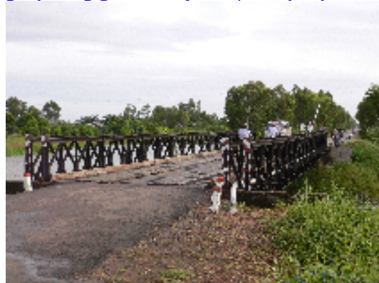
Hình 3.35- Cầu ghép bằng giàn Bailey và vị trí lắp ráp các bộ phận trong cầu.
