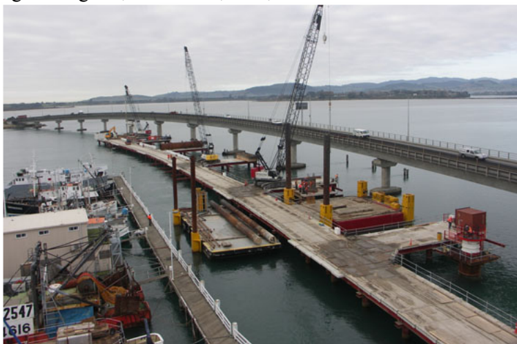
Sàn đạo dùng trong thi công cầu. ( ảnh lấy từ www.transit.govt.nz )
