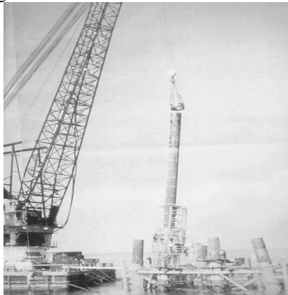
Hình 14.5: Hạ cọc nâng vòng sau khi đặt cọc vào chân giá đỡ. Cọc định vị được khóa sản công tác
