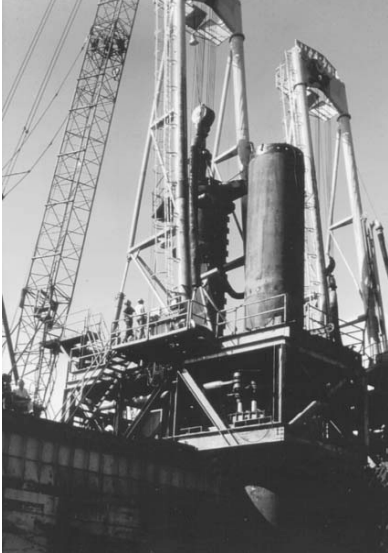
Hình 14.8 - Định vị cọc trong khung công-xôn từ đuôi của tàu cầu, tại Cook Inlet, Alaska
