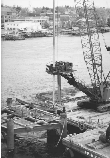
Hình 14.9 - Cọc thi công cầu Rio Niteroi, tại Rio-Đờ-Janero, Bra-xin, được đóng vào trong đá bằng các đầu khoan đặt bên trên cọc.
