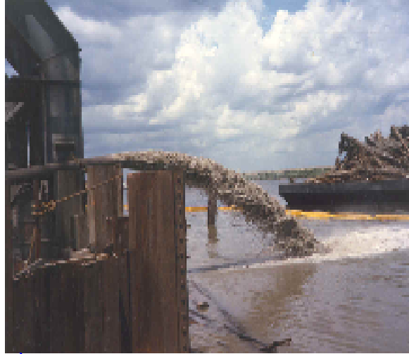
Đào đất bằng biện pháp xói hút. (hình ảnh lấy từ www.javeler.com )
