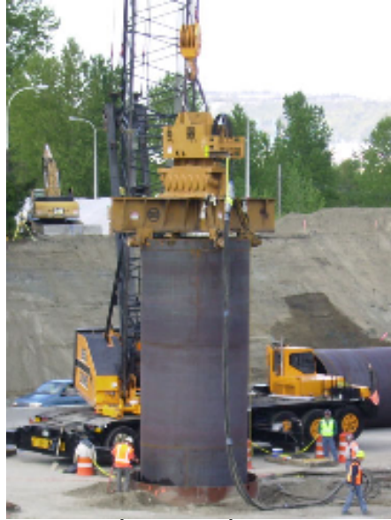
Hạ cọc ống thép bằng búa rung.
