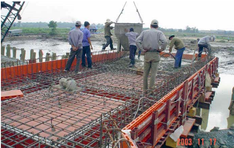
Hình 7.6: Ván khuôn FUVI lắp dựng cho đổ sàn bê tông.
