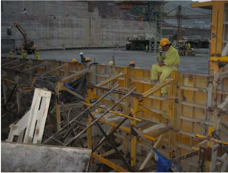
Hình 7.4: Ván khuôn thép trong thi công bê tông đầm lã.
