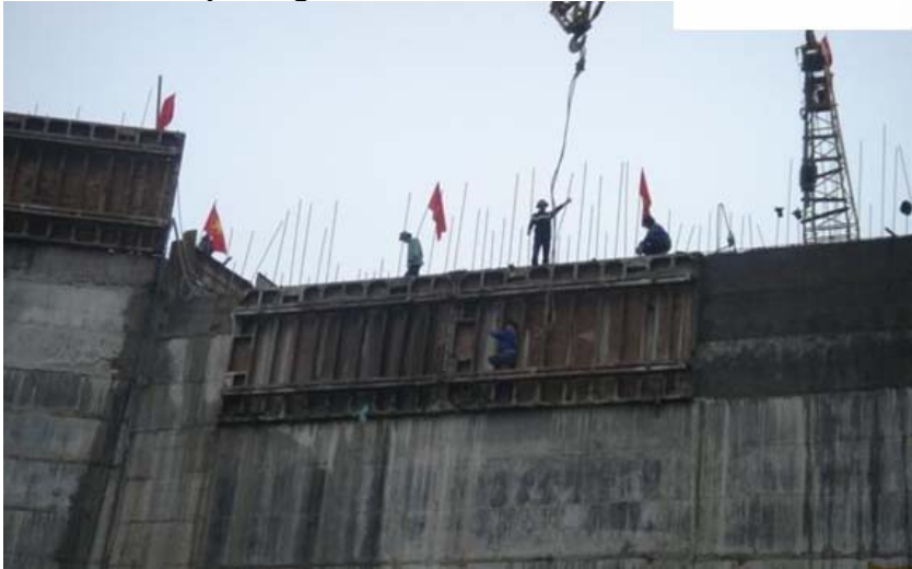
Hình 7.8 : Dựng lắp ván khuôn thép tại công trình Tuyên Quang.
