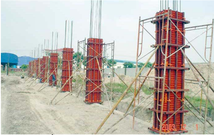
Hình 7.7: Lắp dựng ván khuôn cột- Ván khuôn nhựa- FUVI.
