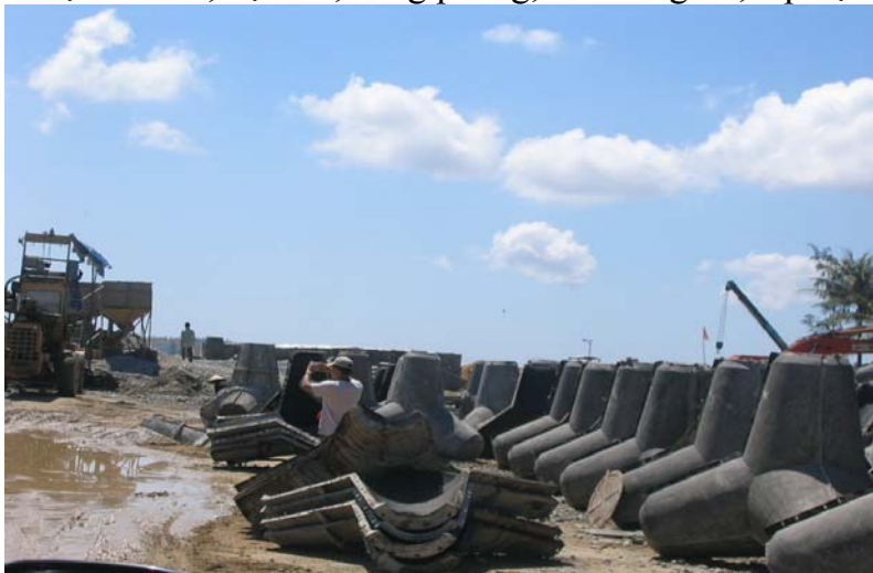
Hình 7.3: Ván khuôn đổ bê tông cục Tetrapods
