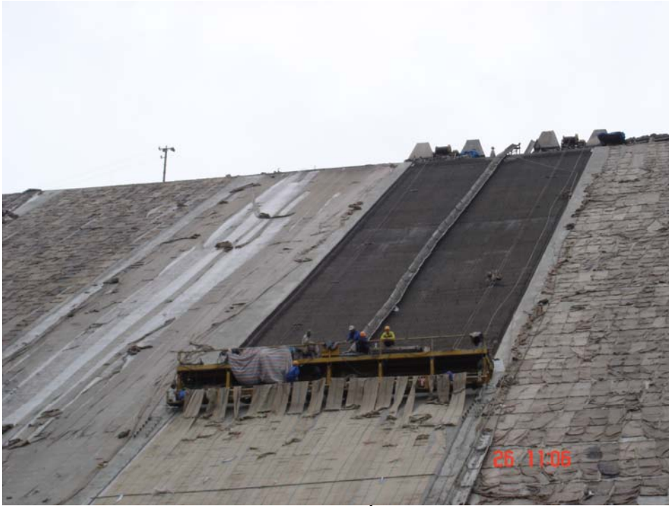
Hình 7.9: Ván khuôn trượt thi công tấm bản mặt- Đập Tuyên Quang.
