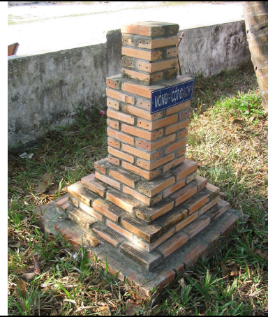
Hình 2.20 - Móng đơn dưới cột xây gạch
