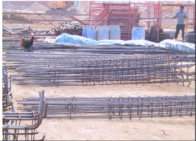
Hình 2.22 - Thép cột được bê về các phía để liên kết với tầng móng
