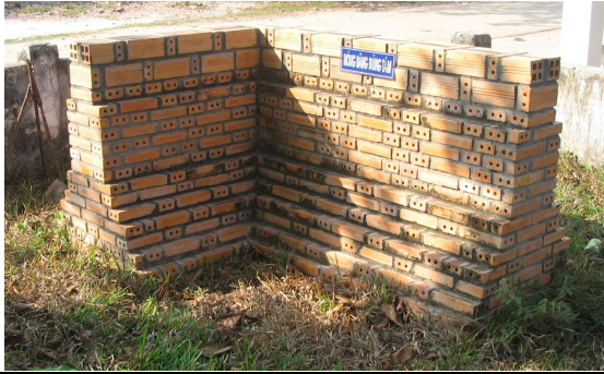
Hình 2.19 - Móng băng dưới tường xây gạch
