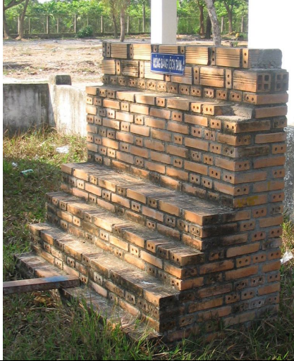
Hình 2.21 - Móng khe lún dưới tường xây gạch
