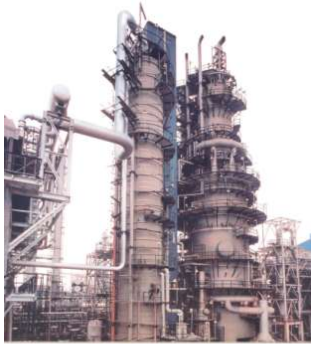
Hình 1.8 Hình ảnh tổng thể phân xưởng cracking xúc tác cận tầng sôi trong nhà máy lọc dầu
