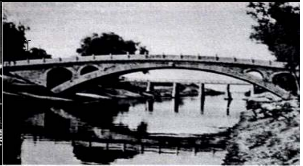
Cầu An Tê bằng đá (China) được xây dựng năm 605
