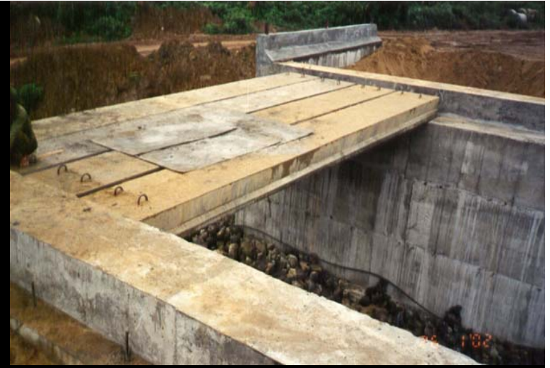
Cầu Bản BTCTU'ST (Đường Hồ chí Minh)
