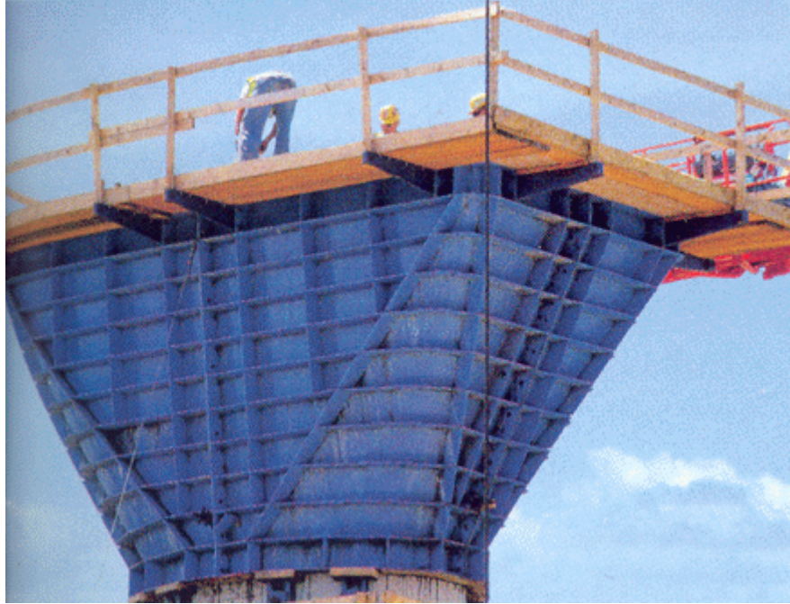
Ván khuôn thép thi công mũ trụ cầu
