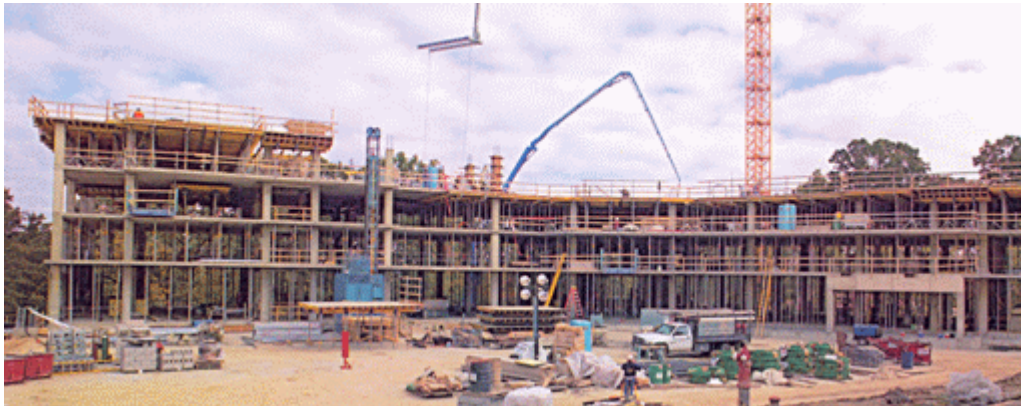
Sử dụng ván khuôn Dokaflex để thi công các sàn tất cả các tầng Trung tâm Hưu trí ở Madison
