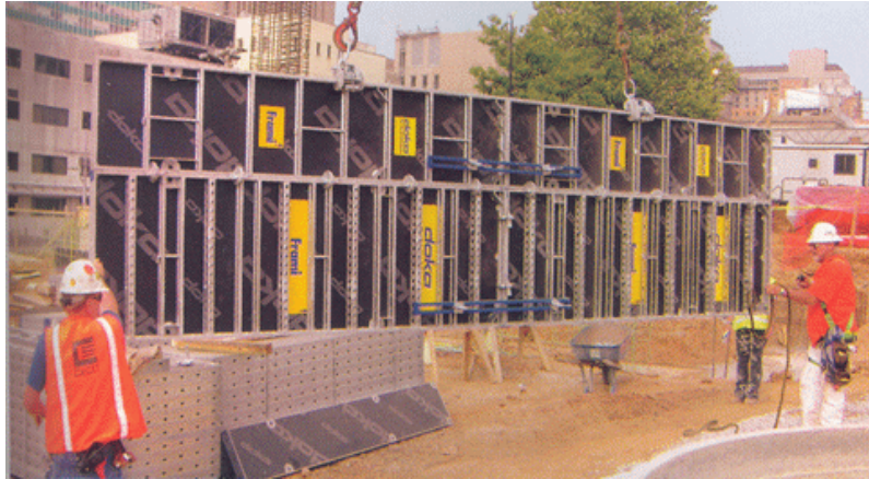
Các ô đục lỗ hệ logic tạo ra các đơn vị nâng cầu định vị nhanh và rút ngắn thời gian cầu
