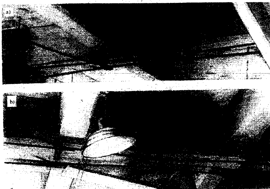
Hình 68. Gia cường dầm bằng các thanh cằng kết hợp, ứng suất trước, gồm 2 \phi 30.
